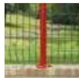
Sloupek na základové desce
