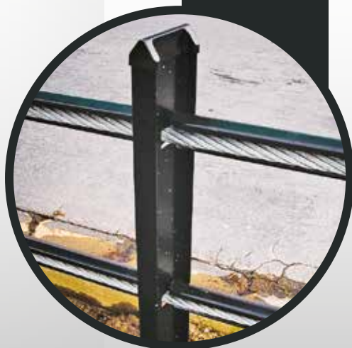
VEDENÍ LAN ZADNÍ STRANOU VÝSTUHY
