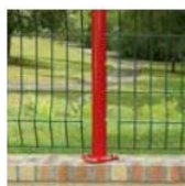
S kotvením plátem
